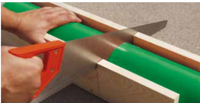
Abbildung 10 Rohrabkürzung mit einer Säge
