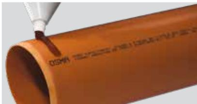
d) das gerade Ende des Rohrs bis zum Anschlag hineinschieben. Dann am geraden Ende des Rohres den Rand des Stutzens markieren (z.B. mit einem Blei- oder Filzstift). Das gerade Ende anschließend aus dem Stutzen um 3 mm je 1 m Rohrbaulänge, jedoch mindestens um 10 mm, herausziehen.
